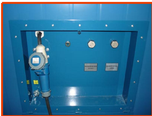
Коллектор для подключения гидравлических рукавов/ кабеля электропитания
